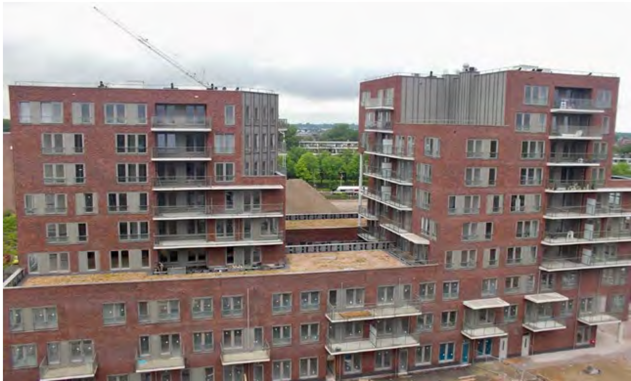
Woningen en appartementen De Wijkerbaan in aanbouw.
