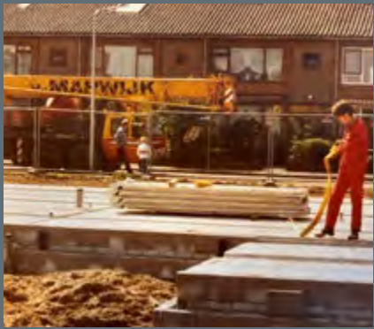
▲ Aanleg van de fundering woningen Margrietlaan in Katwijk.
