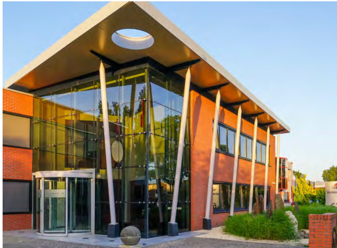
In 2018 krijgt het complete bedrijfspand een verfrissende facelift: klaar voor de toekomst.
