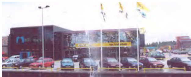
Het Motorhuis is vaste klant, hier de nieuwbouw van Het Motorhuis in Gouda.
