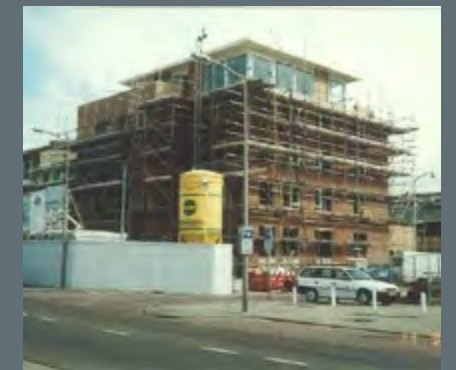
▲ Appartementencomplex De Lindehof in aanbouw, Boulevard te Katwijk.
