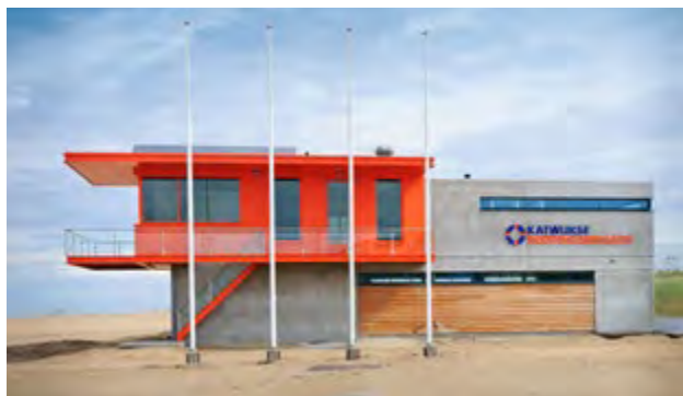
Bouw van 2 strandposten op het strand in Katwijk.
