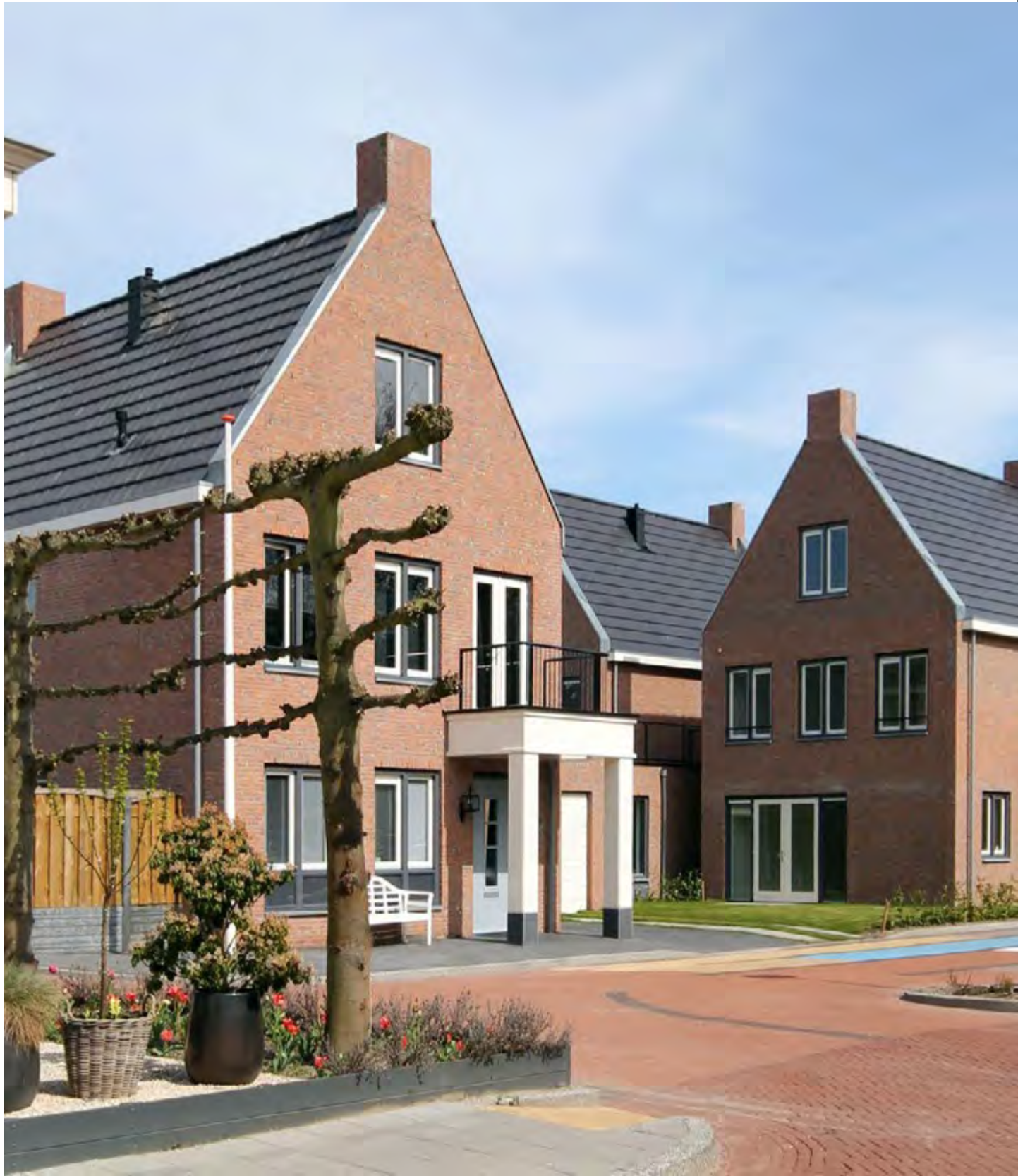
25 woningen en appartementen bouwproject De Hovenier te Warmond.
