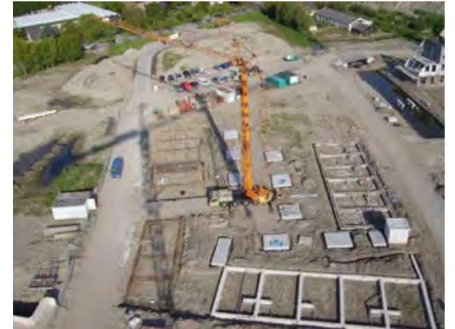
Start bouw werkzaamheden eengezinswoningen in 't Duyfrak.
