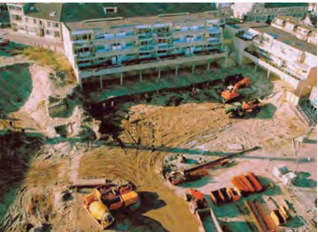
De bouwput van De Zwaaiikom, project Princehaven.
