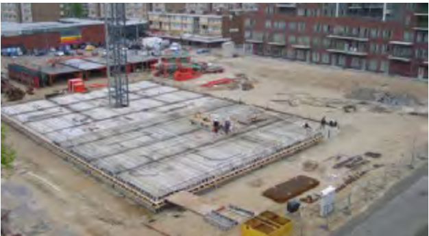
Fundering van de woontorens in De Wijkerbaan.
