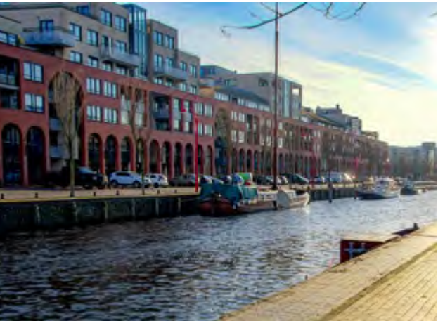
Met de realisatie van Princehaven doet Van Rhijn Bouw veel ervaring op met grootschalige hoogbouw.
