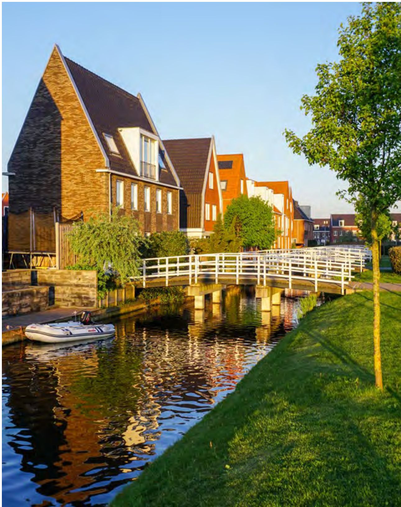
De nieuwe wijk 't Duyfrak: waterrijk wonen met karakteristieke bruggetjes.
