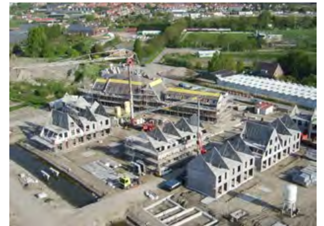
Bouwproces eengezinswoningen in 't Duyfrak in volle gang.
