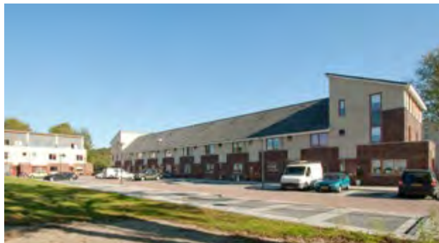
Waterrijck: speelse mix van hoogbouw en eengezinswoningen.
