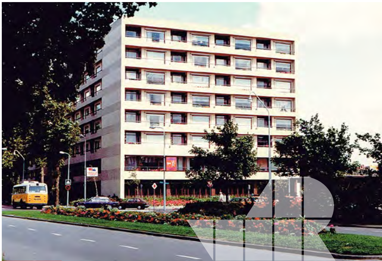
De eerste opdracht: de bouw van verzorgingstehuis Rosenburch fase 1 aan de Vijf Meilaan in Leiden.
