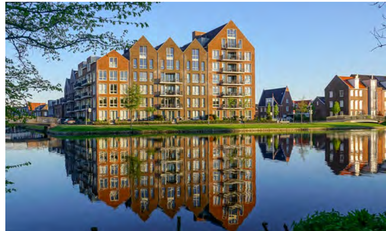
Appartementencomplex aan het water van de Oude Rijn, 't Duyfrak Valkenburg ZH.
