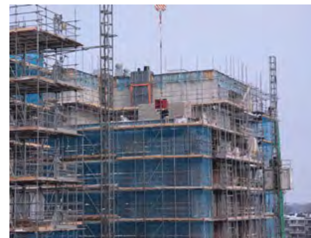
Hoogbouw, de lucht in, maakt bij De Wijkerbaan een flink onderdeel van het werk uit.
